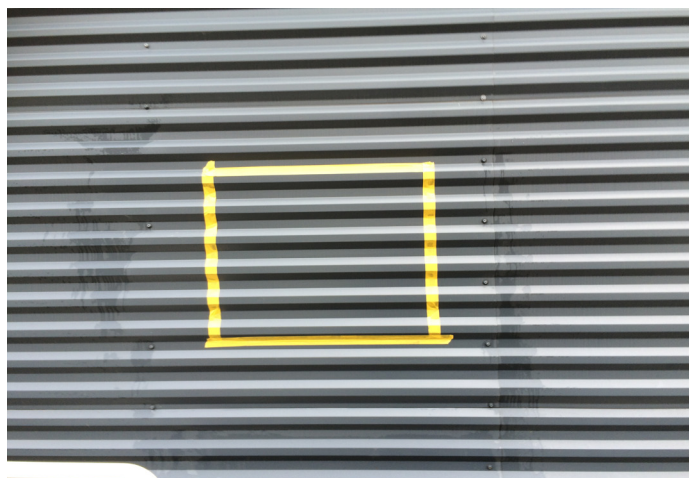
Aluminium gevelbeplating gereinigd middels PreClean ® AL10F (situatie afhankelijk).
